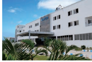
Rudrapur Fabrika (Yeşil Bina)
