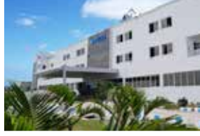
Rudrapur Fabrika (Yeşil Bina)
